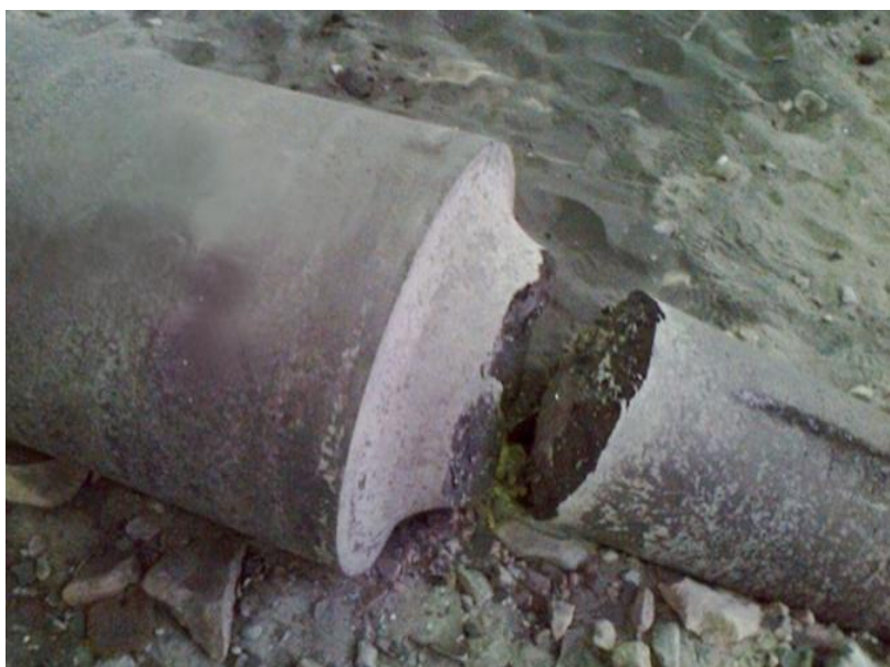
Obr. 12. Porušení těla a čepu hutního válce
